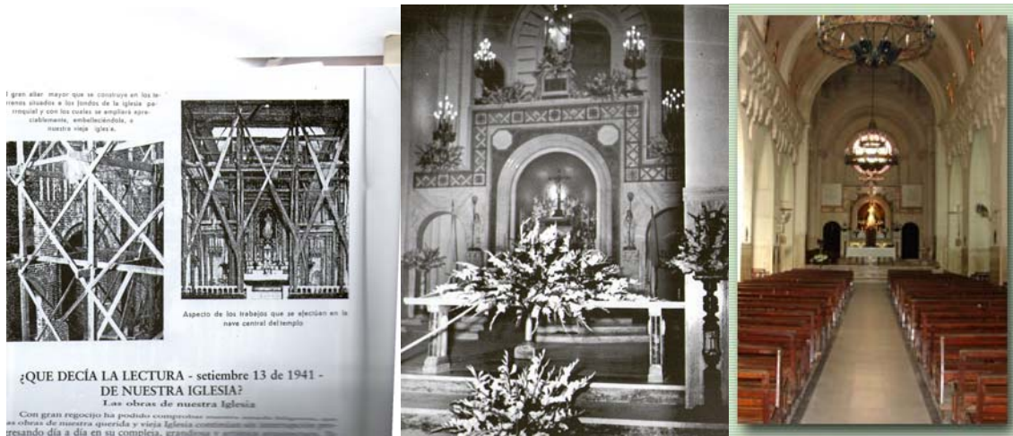
Foto 8: Modificación del Atrio en 1941 a cargo Ing. Pollak y Foto 9: actual (Flia. Goni-Traverso).
