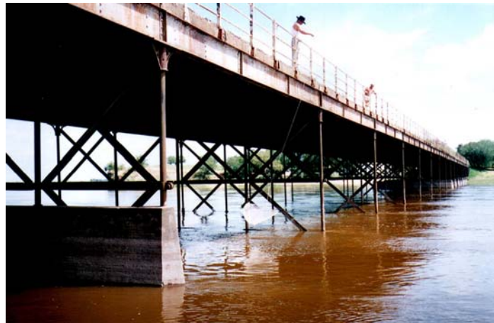
Figura 9 – Vista actual del puente La Postrera sobre el río Salado
