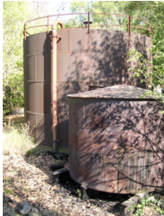
Fig.13. Depósitos de combustible.
