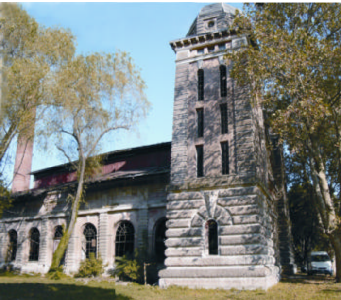
Fig. 2. Estación Central, vista Sudeste.
