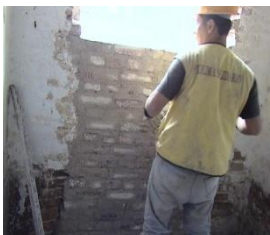
Fig.16 Proceso restitución de muros.
