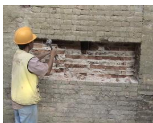
Fig.22 Detalle muro restitución parcial.
