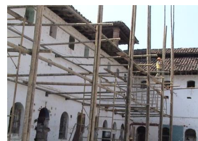
Fig.15 Instalación estructura de sobre-cubierta.
