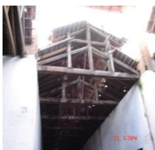
Fig.24 Estructura cubierta Cercha Rey.
