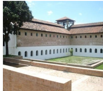
Fig.30 Vista estado actual edificio restaurado.
