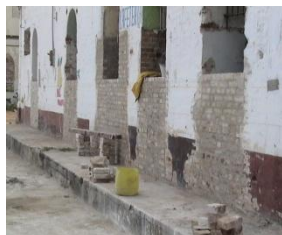
Fig.17 Vista restitución fachada.
