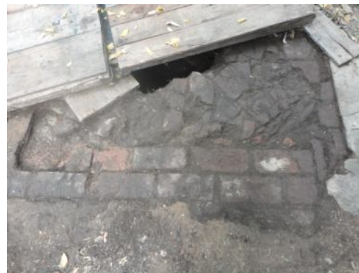
Fig. 12 - Parte de la boca del pozo
