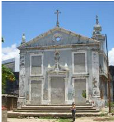
Figura/Fotografia 20. Fachada Frontal Igreja de N. S. do Pilar Fonte: Renata Lopes
