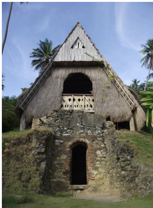
Figura 4 – Ruína do forno de cal com cobertura [18]
