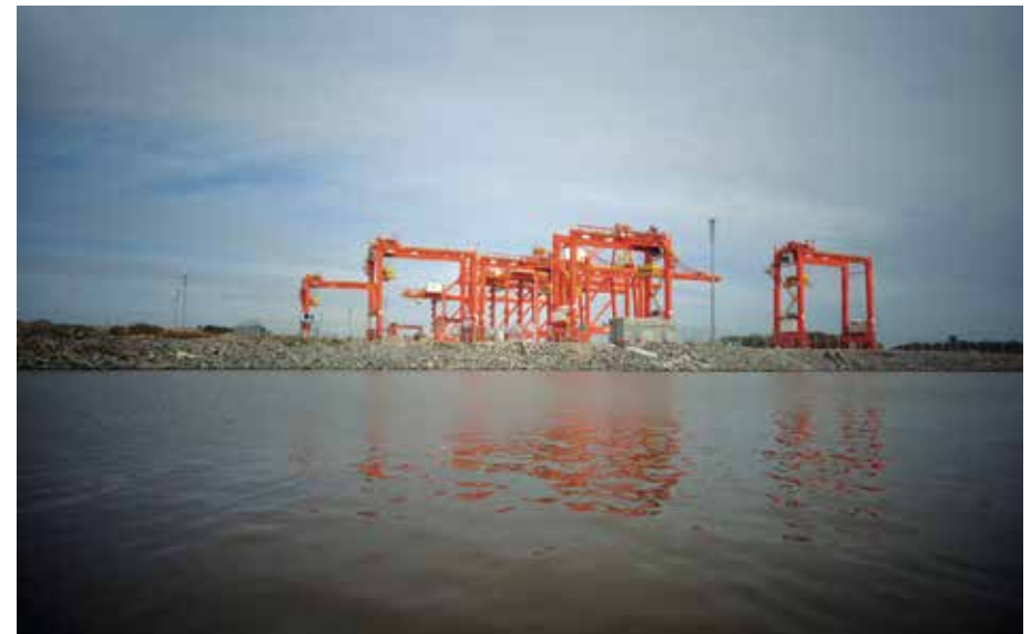
Las grúas de la Terminal de Contenedores
