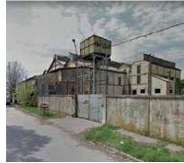
Antigua Usina Eléctrica
