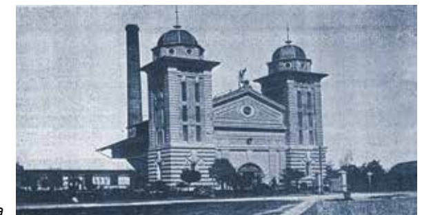
Antigua Usina Hidráulica
