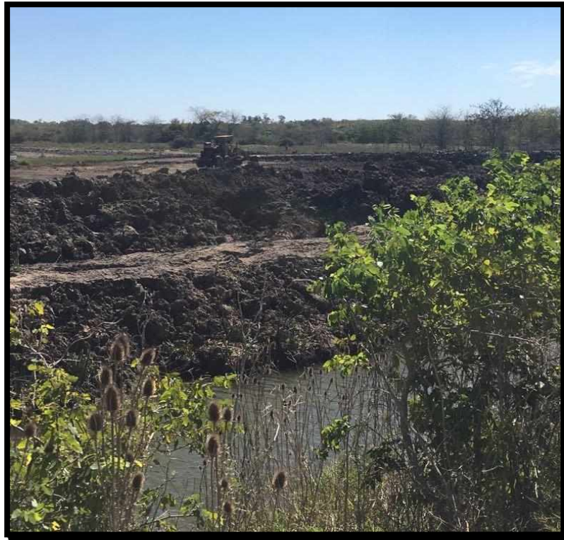
Figura 2: Relleno del humedal para la construcción de terraplenes, produciendo su sequedad.
