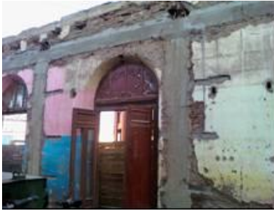
Estructura sobre dintel
