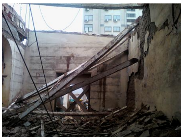
Demolicion estructura de techo
