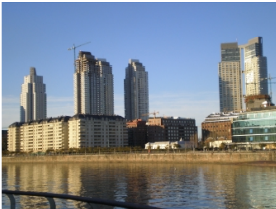
Fig. 3.- Buenos Aires, Puerto Madero. Un área patrimonial sometida a fuertes presiones inmobiliarias.
