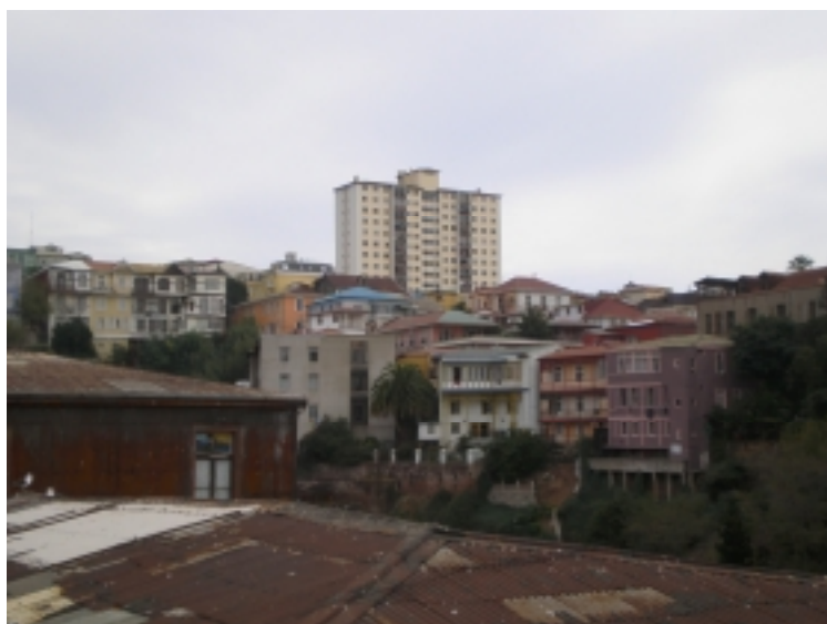
Fig. 5.- Valparaíso, Chile. Irrupción inarmónica de arquitectura contemporánea en un paisaje urbano homogéneo, gestado en el tiempo con una fuerte incidencia de las condiciones topográficas del sitio. Una situación común en las ciudades latinoamericanas.
