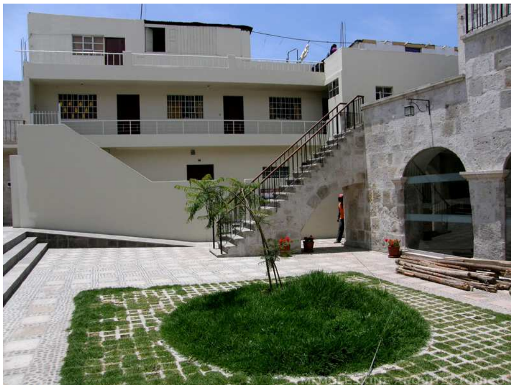
Figura 4: En pleno trabajo de Recuperación de la arquería
