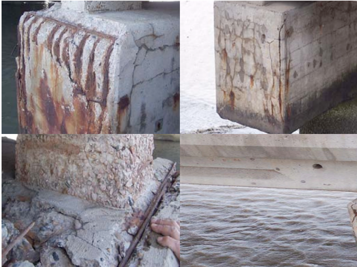
Figura 1: Relevamiento de la estructura
