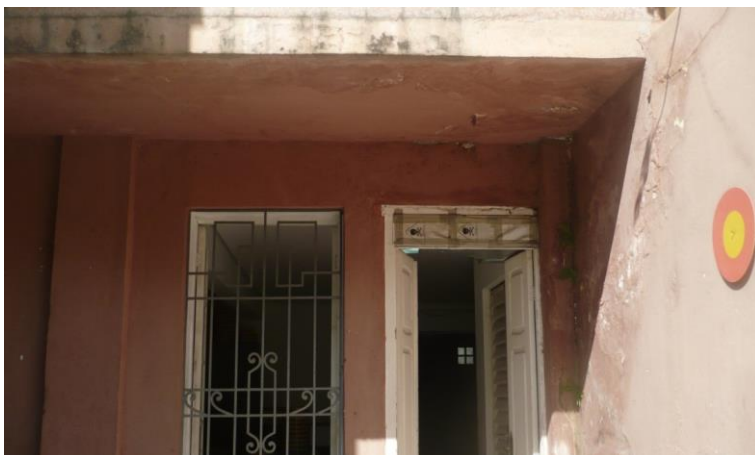
Figura 5 - incidência de radiação solar direta. Foto: Camilla Maia
